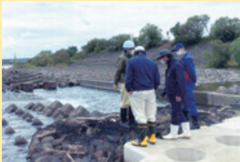
“これでは遡れない！” 魚道の確認をする役員の皆さん。早期の改良を要望したい。（渡場床固）
