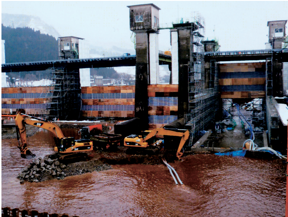
出水止まらぬ!! 難工事〈咲花頭首工大改修→魚道改良に着手〉
