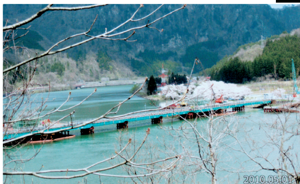
*揚川橋、仮棧橋（阿賀町小花地）
