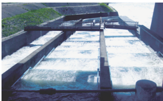
改良された左岸魚道...
