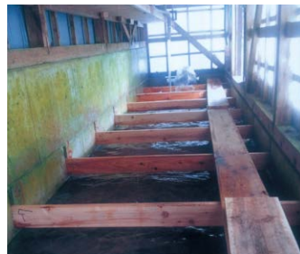
流れるプールで経費削減 大川漁協アユ中間育成施設
